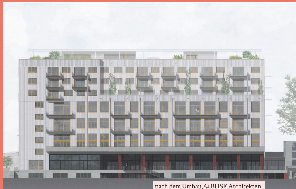
nach dem Umbau, © BHSF Architekten
